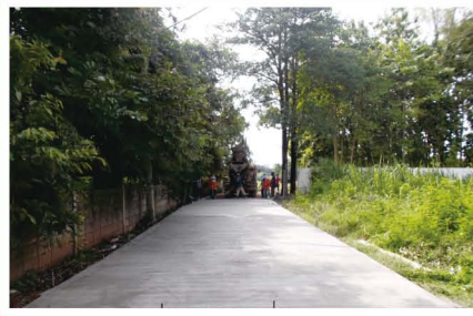
๖. โครงการก่อสร้างถนนคอนกรีตเสริมเหล็กซอยพิภพทรคอร์ต (ต่อ) หมู่ที่ ๑๑
